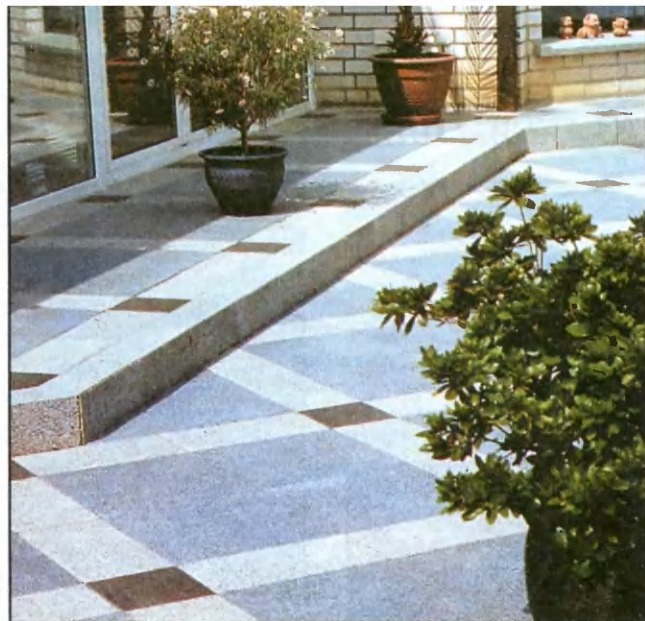
Это покрытие устроено из старых плит размерами 50х50 см и новых плит двух различных форматов и цветов.
