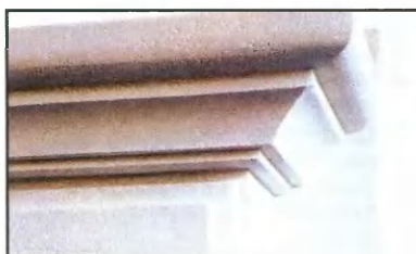
Финишная окраска (и тоже — термостойкой краской) скрывает даже мелкие щели между деталями портала, что придает ему вид монолитного сооружения.
