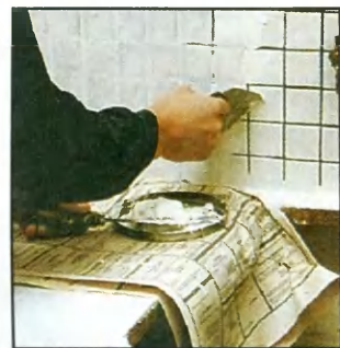
Швы заполняют с помощью широкого гибкого шпателя.
