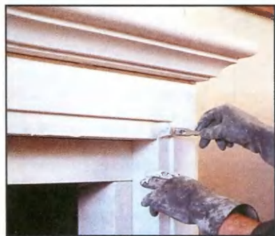
Финишная окраска (и тоже — термостойкой краской) скрывает даже мелкие щели между деталями портала, что придает ему вид монолитного сооружения.
