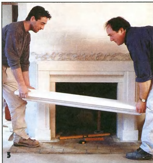
Заключительная монтажная операция — установка каминной полки. Выполнять ее лучше вдвоем, предварительно обильно промазав клеем стенку камина.
