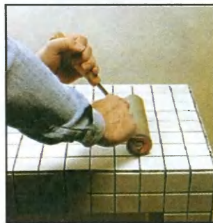
Для лучшего соединения с клеем плитку прикатывают валиком.
